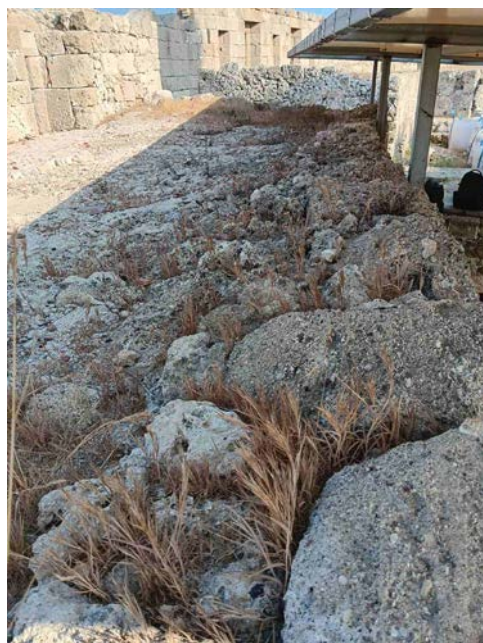
Λεπτομέρεια υφιστάμενης κατάστασης δαπέδου
