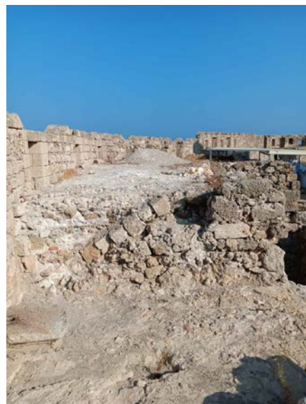
Υφιστάμενη κατάσταση έπαλξης
