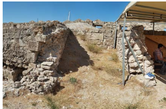
Σημείο Κατασκευής της σκάλας με τα εκατέρωθεν τοιχία τα οποία θα επισκευασθούν
