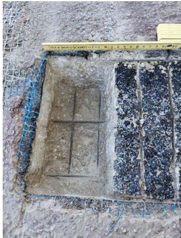
Διερευνητική τομή στο υφιστάμενο τελικό υπόστρωμα (ισχυρή τσιμεντοκονία με τον απαραίτητο σιδηρό οπλισμό)
