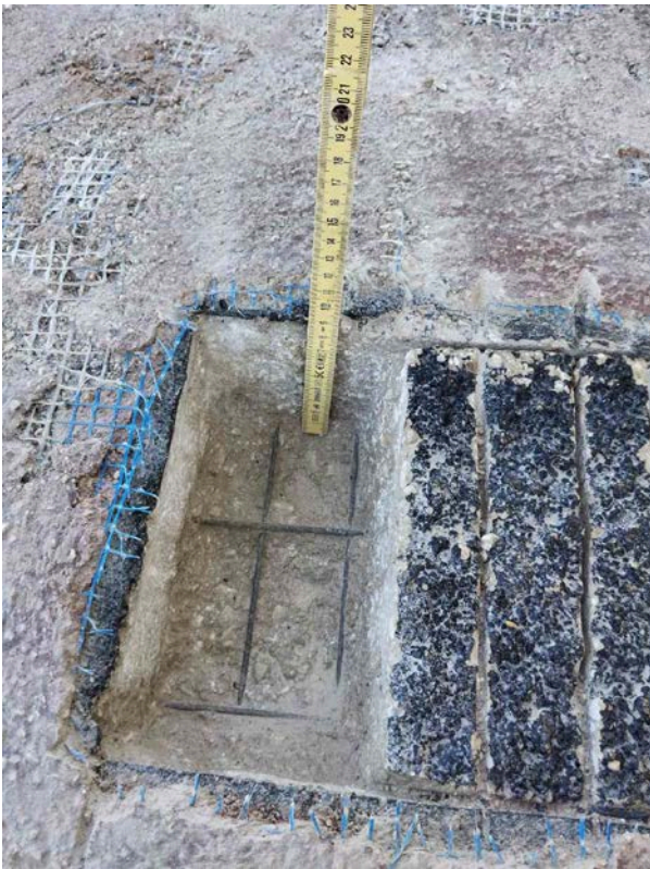
Διερευνητική τομή στο υφιστάμενο τελικό υπόστρωμα (ισχυρή τσιμεντοκονία με τον απαραίτητο σιδηρό οπλισμό)
