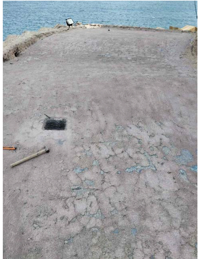
Αφαίρεση της υφιστάμενης παλαιάς υγρομόνωσης
