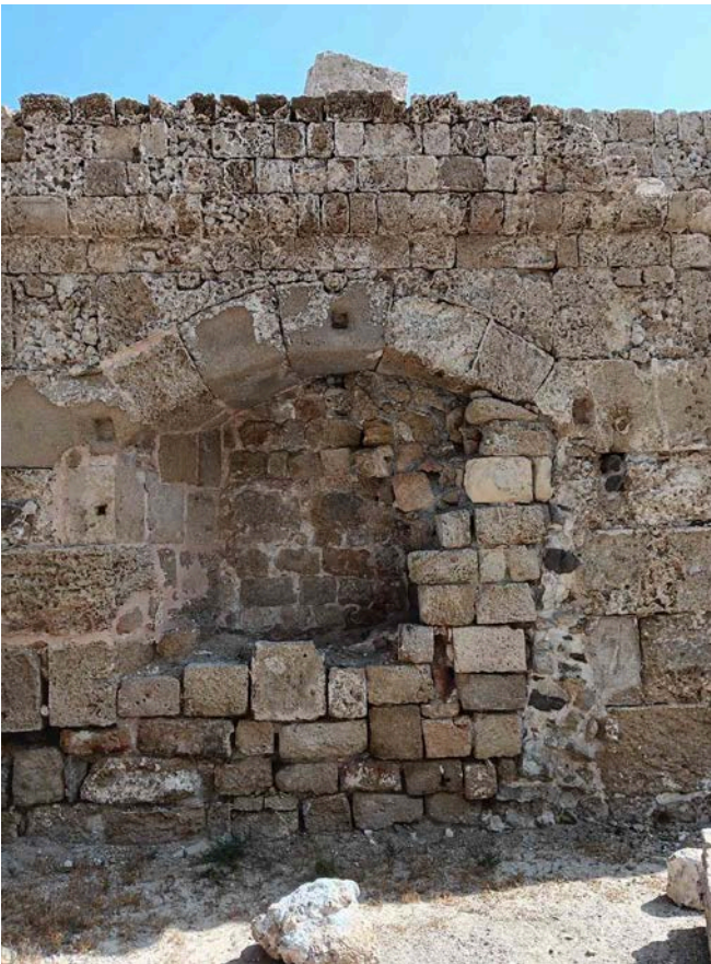
Υπάρχουσα κατάσταση κανονιοθυρίδας επέμβασης
